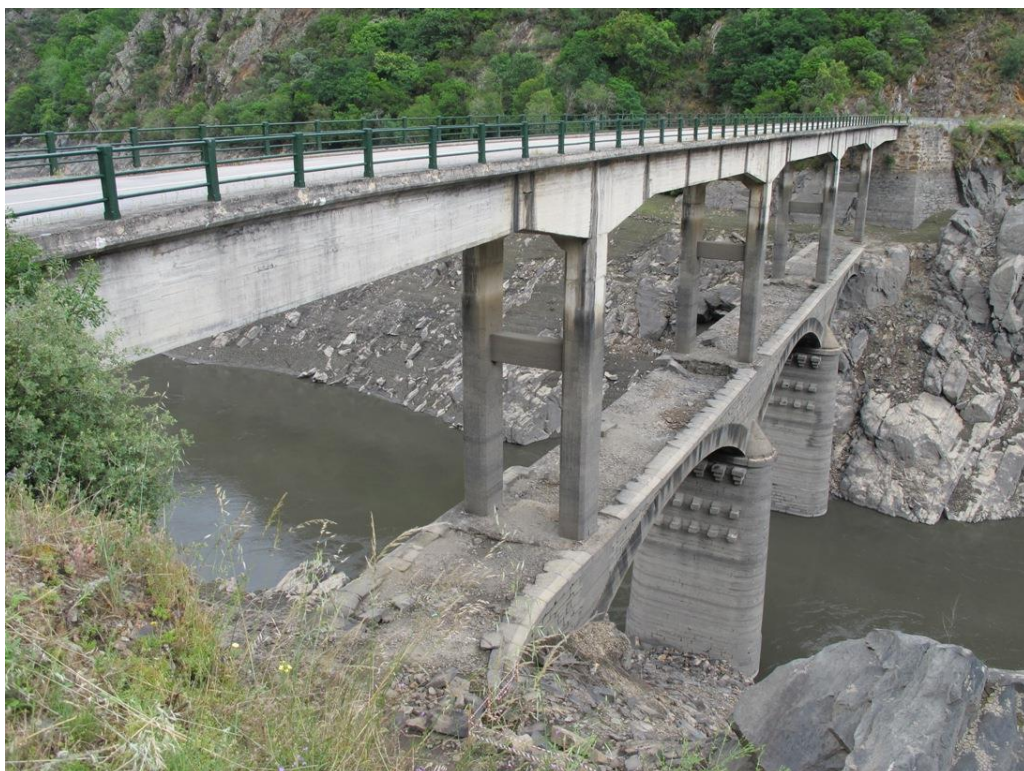
Puente de Paradela. Fuente: imágenes cedidas por Manuel Durán, ingeniero de caminos
