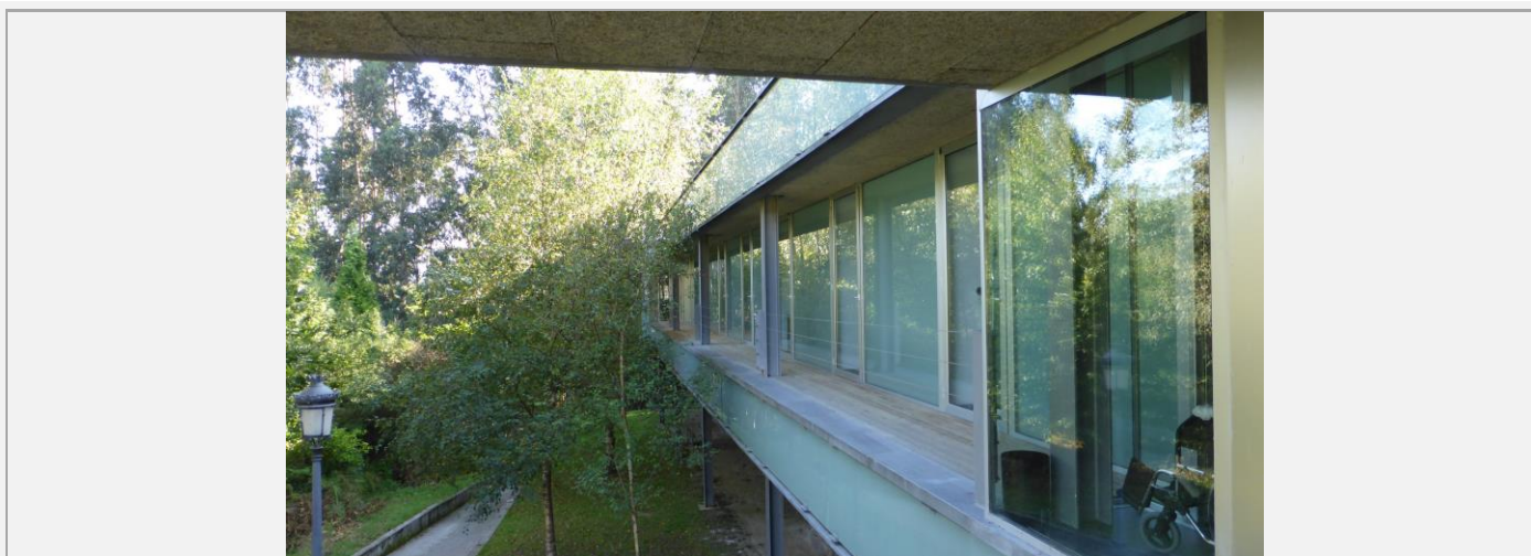
Elemento Carpinterías, barandilla
