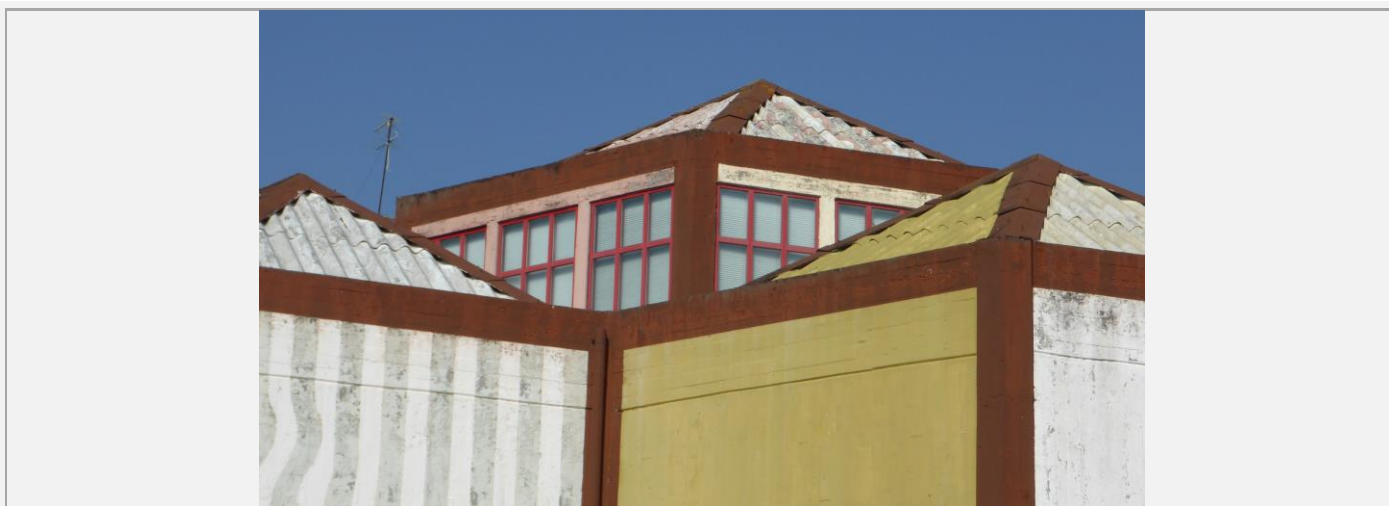
Elemento Carpinterías, cuberta
