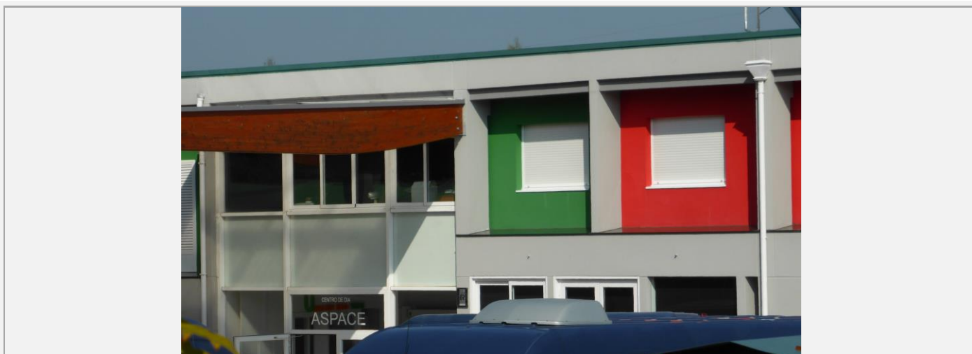
Elemento Carpinterías, baixante, pérgola
