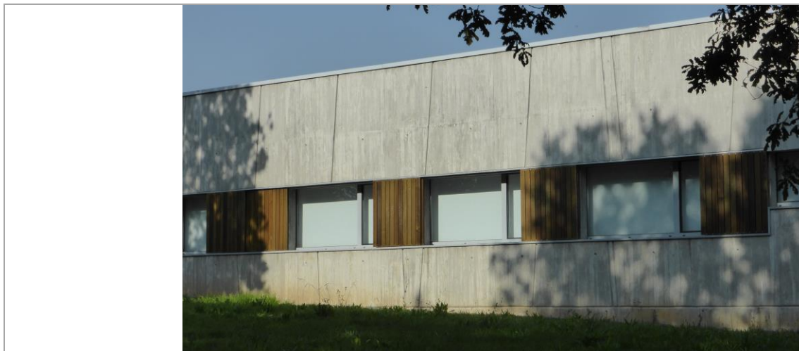
Elemento Fondo, carpinterías, defensas
