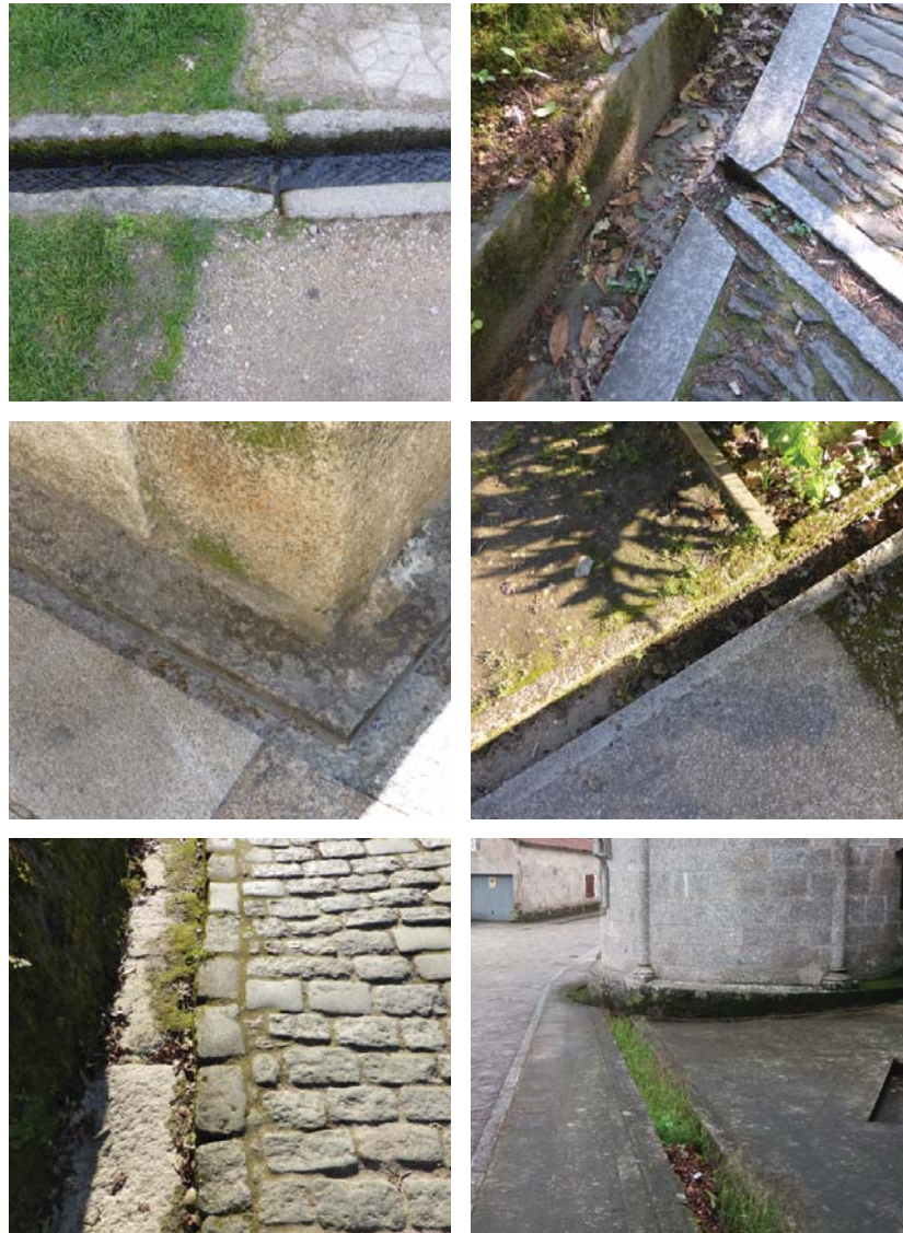
Figura 162. Canalizacións en superficie para a auga
