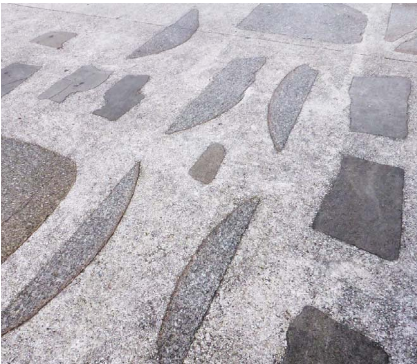
Figura 46. Reutilización de lousas de granito preexistentes en novo pavimento de formigón-pedra na Praza do Curro, Noia
