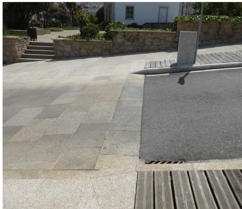
Figura 230. Paso de peóns que continúa o pavimento da beirarrúa á mesma cota. Porto do Son
