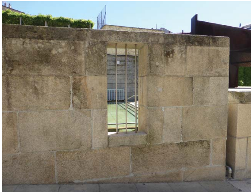
Figura 110. Muro de cantería nas Burgas, Ourense
