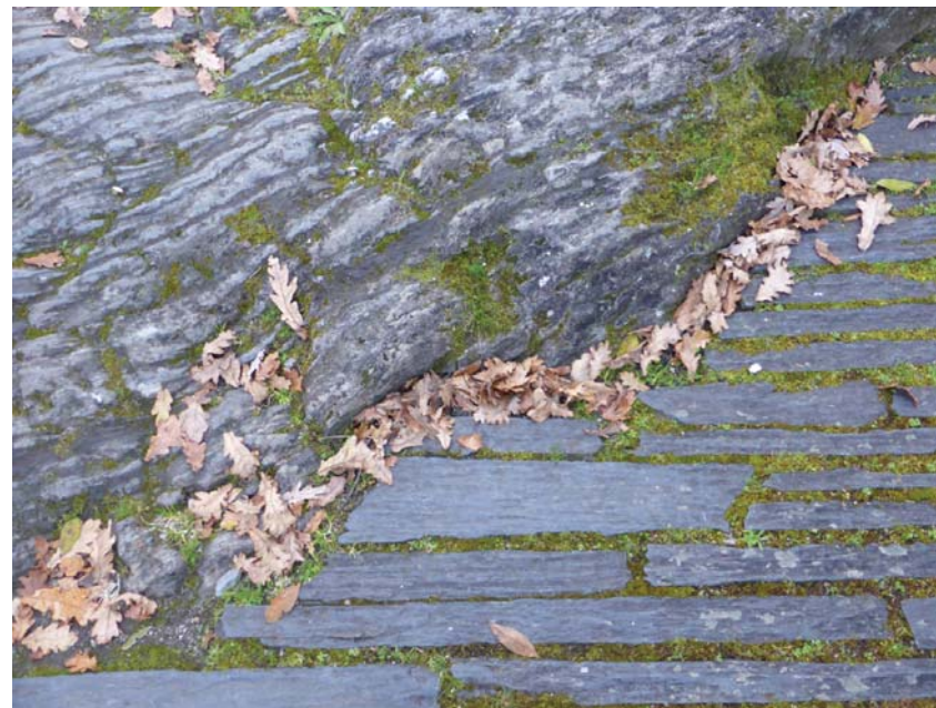
Figura 72. Encontro entre pavimento de lousa e rocha existente. Contorna do Mosteiro de Caaveiro, A Capela
