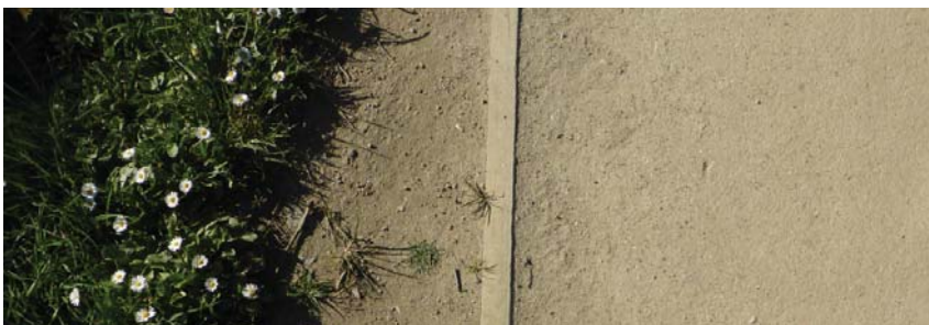
Figura 100. Bordo de madeira en pavimento de terra-cemento
