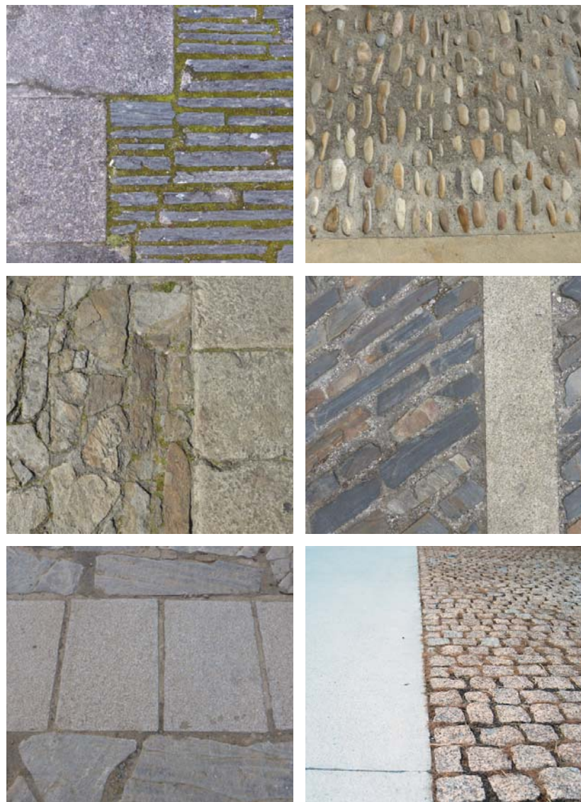
Figura 76. Encontros entre diferentes pavimentos de pedra
