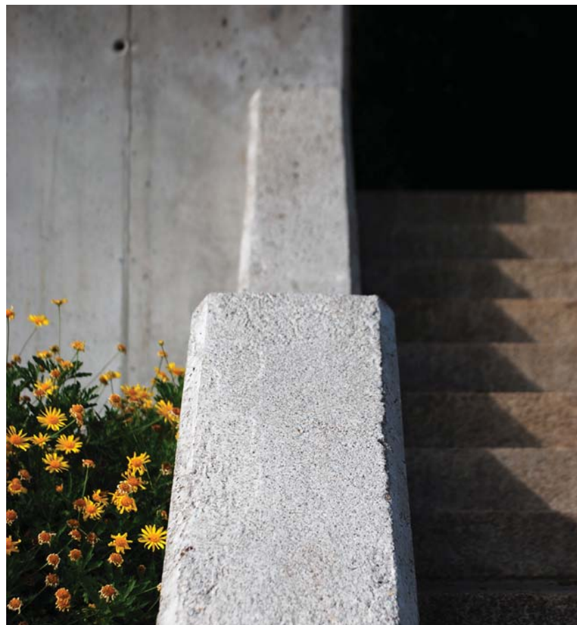
Figura 123. Detalle de escaleira de pedra con pasamáns de formigón
