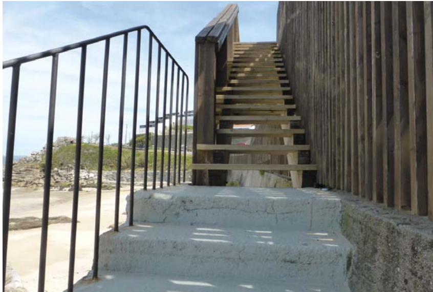
Figura 124. Escaleira na Praia de Arnela, Porto do Son
