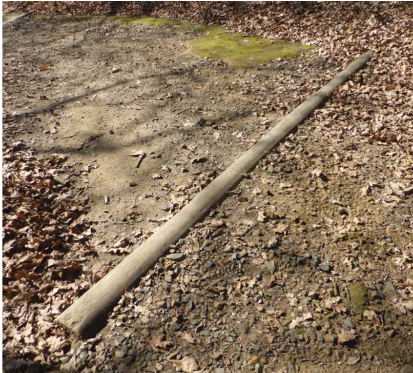
Figura 104. Rollizo de madeira para desvío das augas en pavimento de terra
