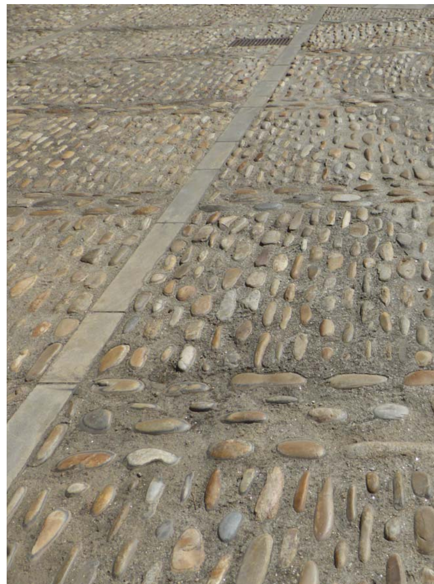
Figura 78. Pavimento de cantos rodados nas Burgas, Ourense
