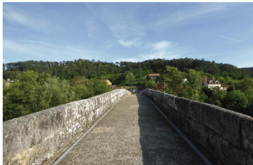
Figura 267. Ponte Ledesma, sobre o río Ulla
