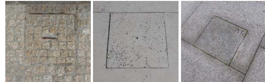
Figura 168. Arquetas integradas no pavimento
