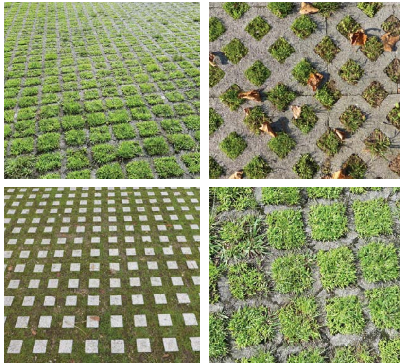
Figura 86. Detalles de celosía prefabricada en aparcadoiro
