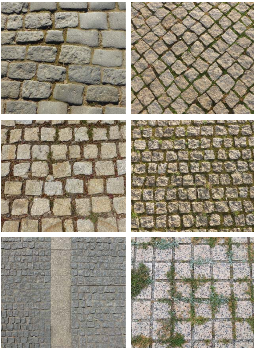
Figura 69. Aparellos de adoquín de granito
