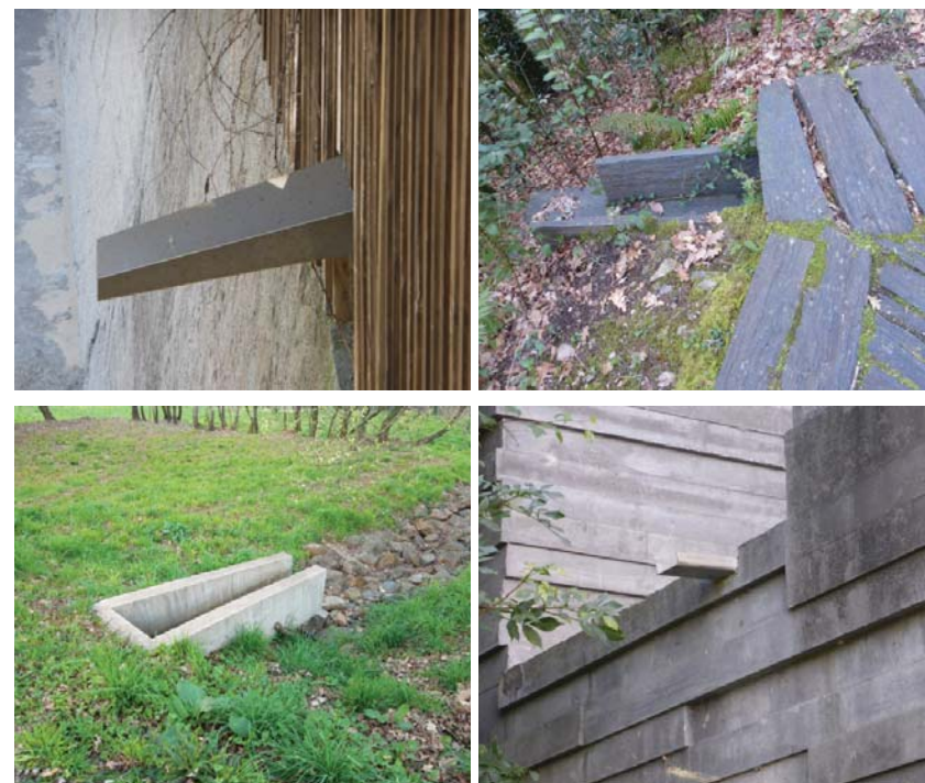
Figura 164. Gárgolas e aliviadoiros de aceiro, formigón e pedra
