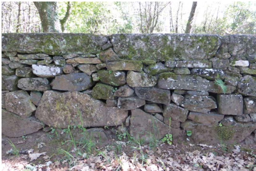
Figura 112. Muros de cachotería
