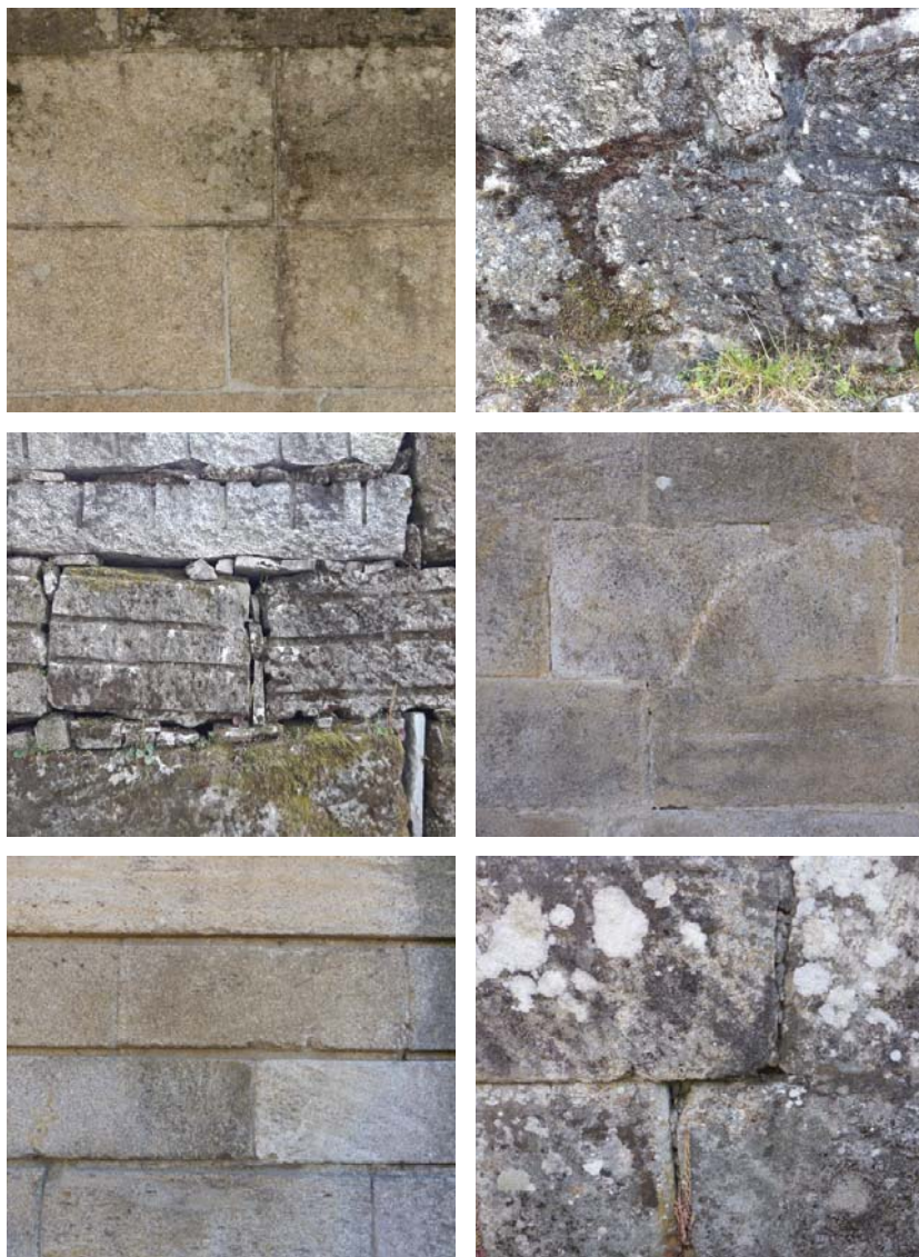
Figura 111. Aparellos de muros de cantería
