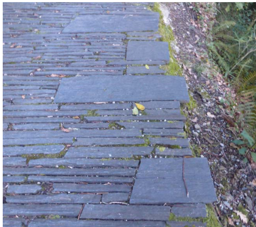
Figura 74. Pavimento de chapacuña de lousa irregular, segundo sae de canteira. Mosteiro de Caaveiro, A Capela
