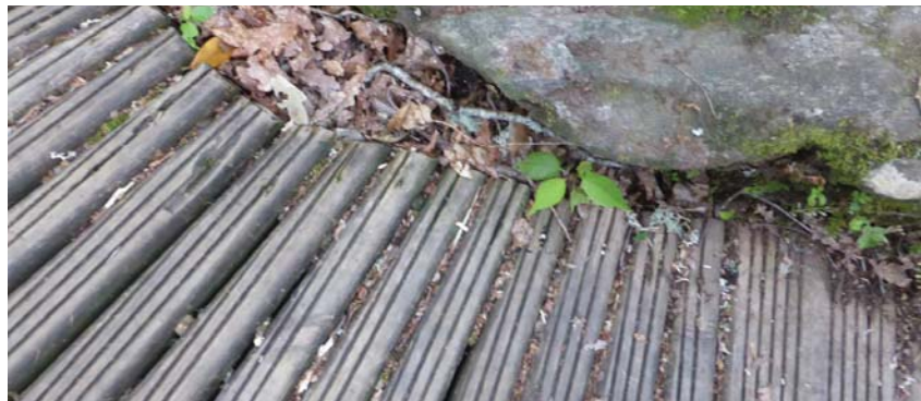
Figura 95. Encontro entre tarima de madeira e rocha existente
