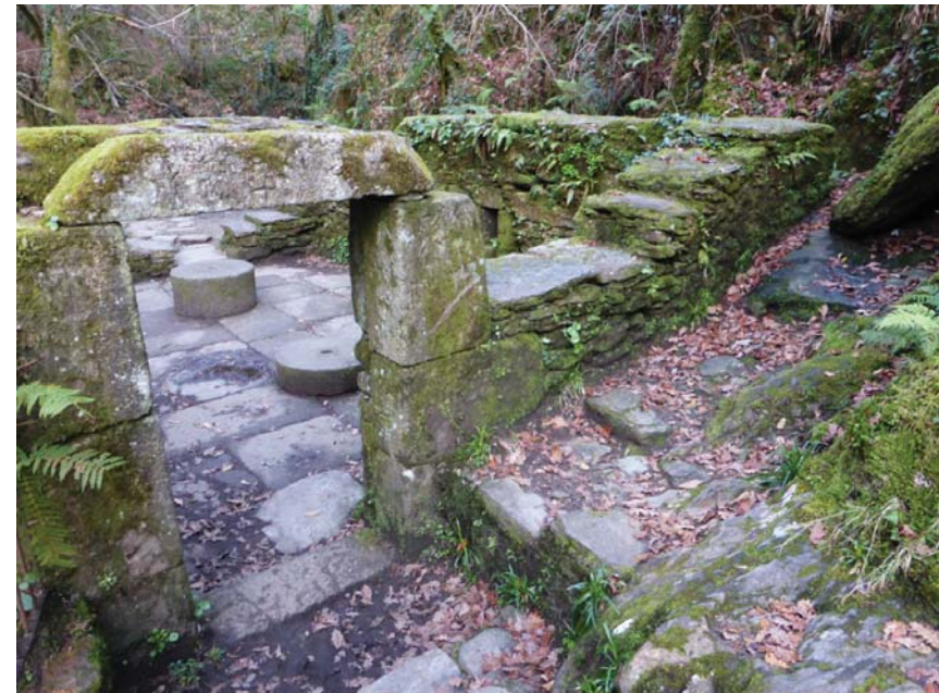
Figura 224. Ruína consolidada do Muíño de Sesín nas Fragas do Eume, A Capela
