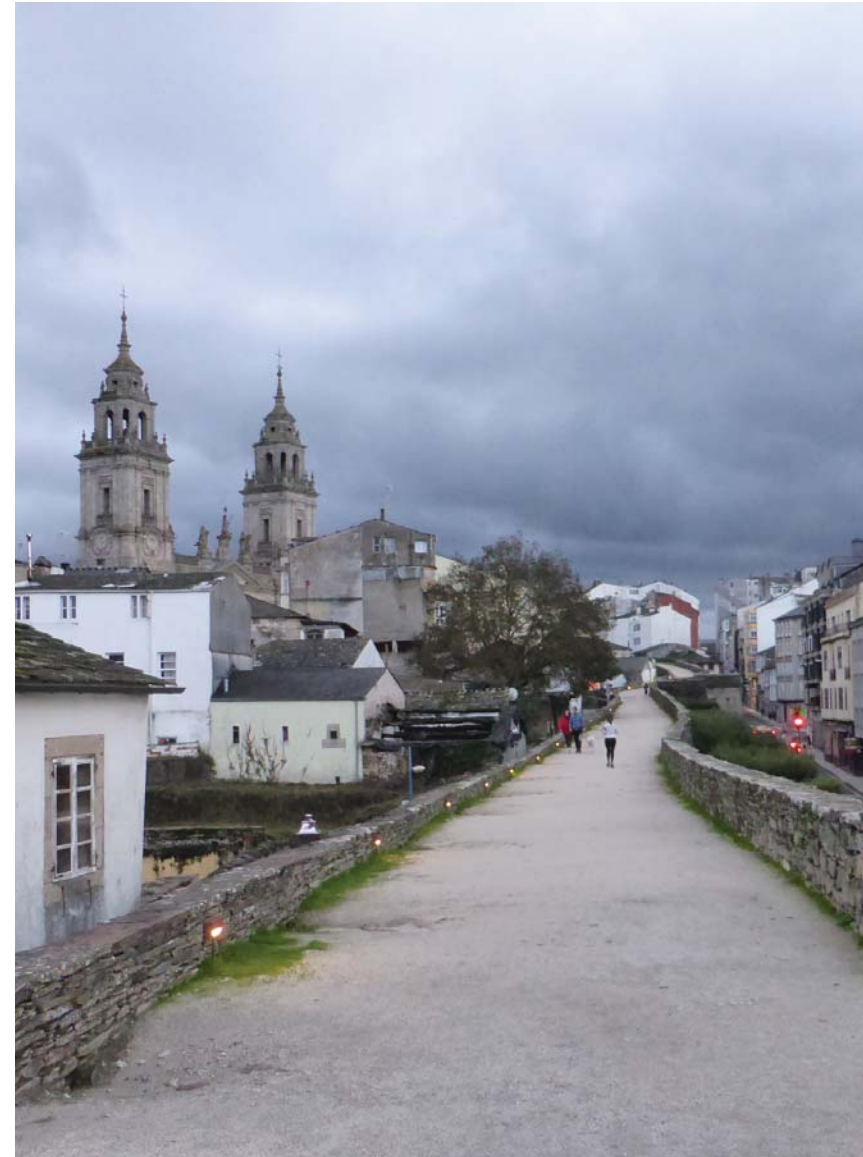
Figura 105. Adarve da Muralla de Lugo
