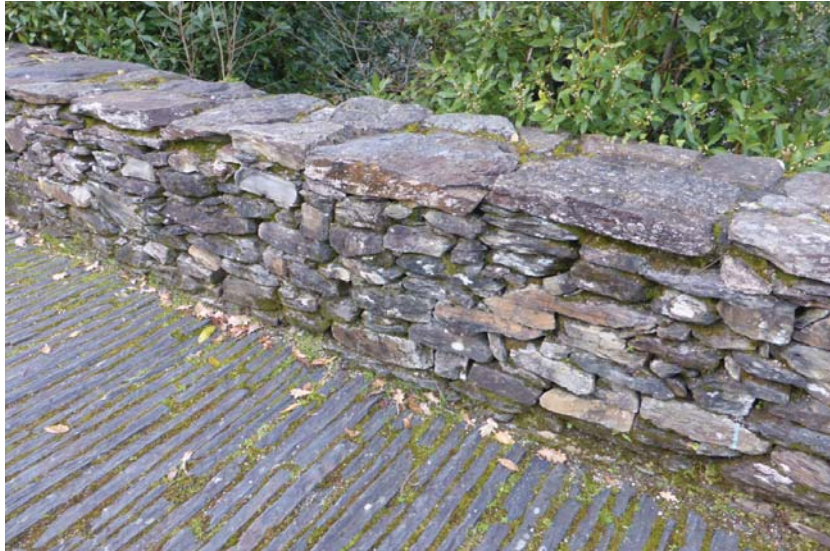
Detalle 25. Muro de cachotería de granito. Escala 1/30
