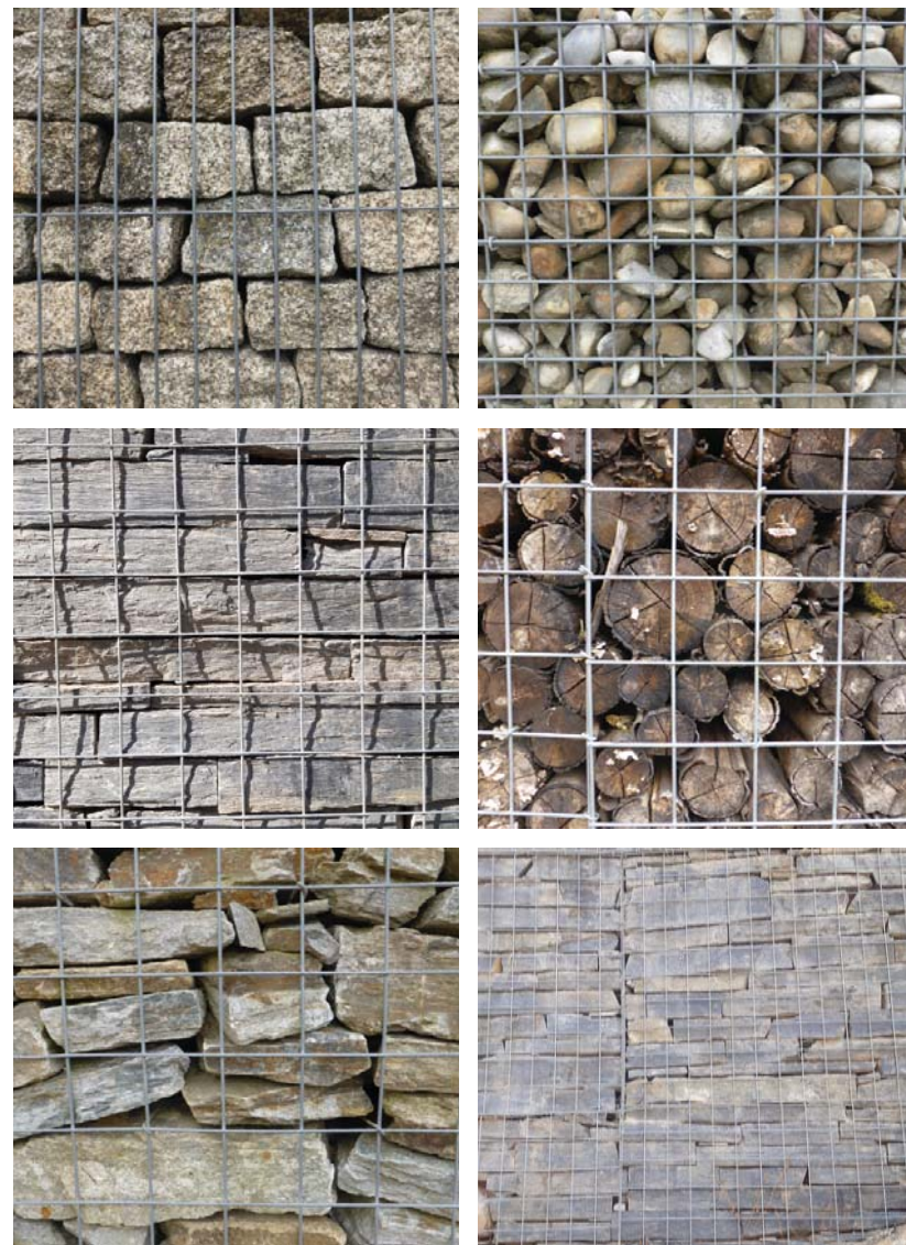
Figura 117. Texturas de muros de gavión
