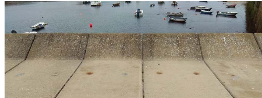
Figura 247. Pavimento de prefabricados de formigón pregados no bordo para realizar un pequeno peto que funciona como defensa integrada. Paseo do Porto de Malpica
