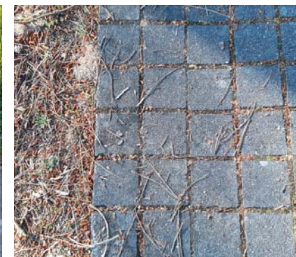
Figura 89. Bordos e encontros de pavimentos de formigón con outros materiais
