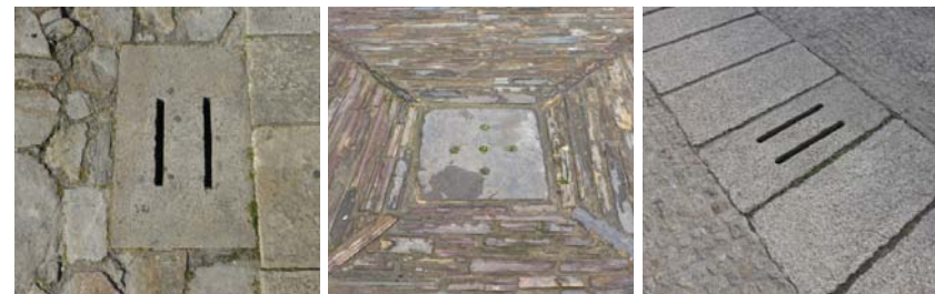
Figura 166. Sumidoiros integrados en pavimentos de pedra
