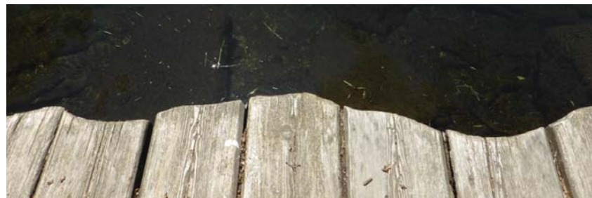
Figura 98. Pavimento de travesas de madeira na beira do río Verdugo
