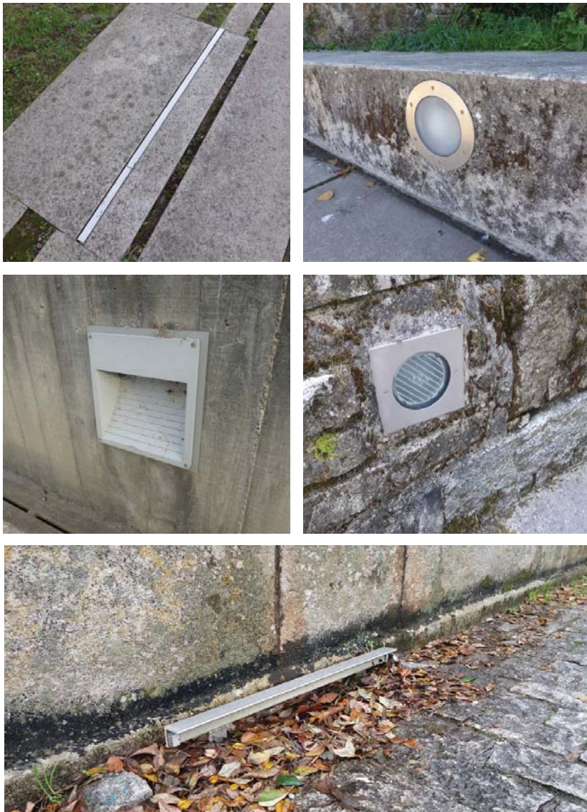
Figura 216. Luminarias integradas
