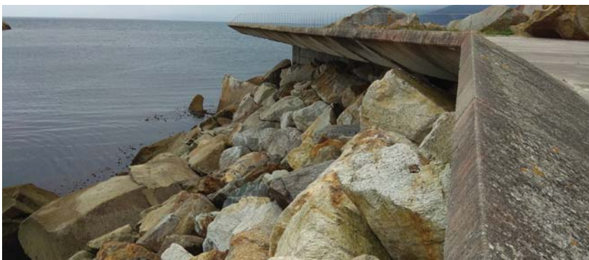
Figura 118. Muro de escollera no Porto de Malpica
