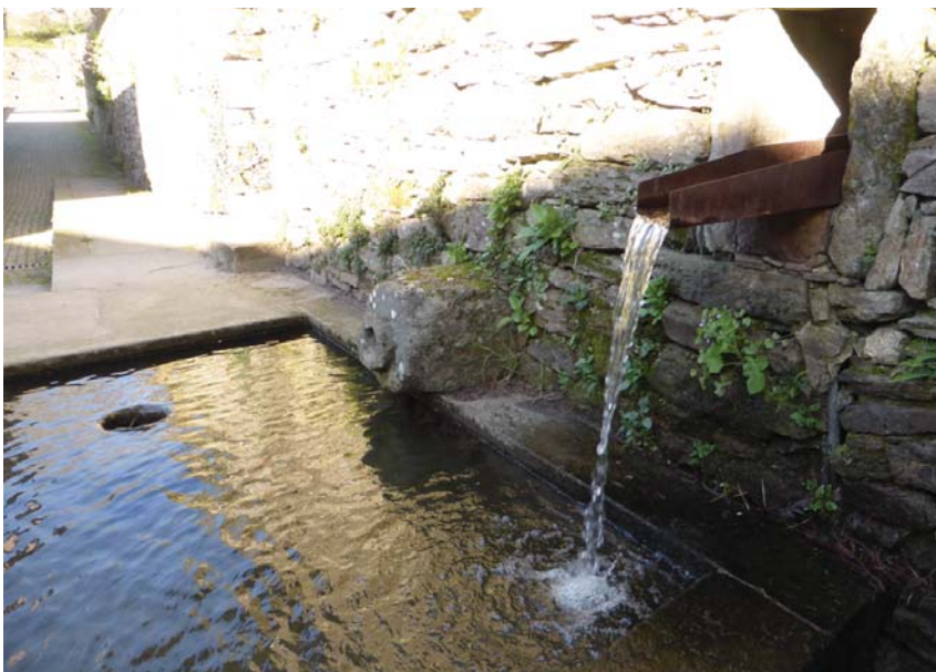
Figura 163. Gárgola de aceiro corten no parque de Bonaval, Santiago de Compostela
