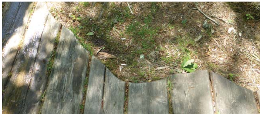
Figura 99. Encontros de pavimentos de travesas de madeira
