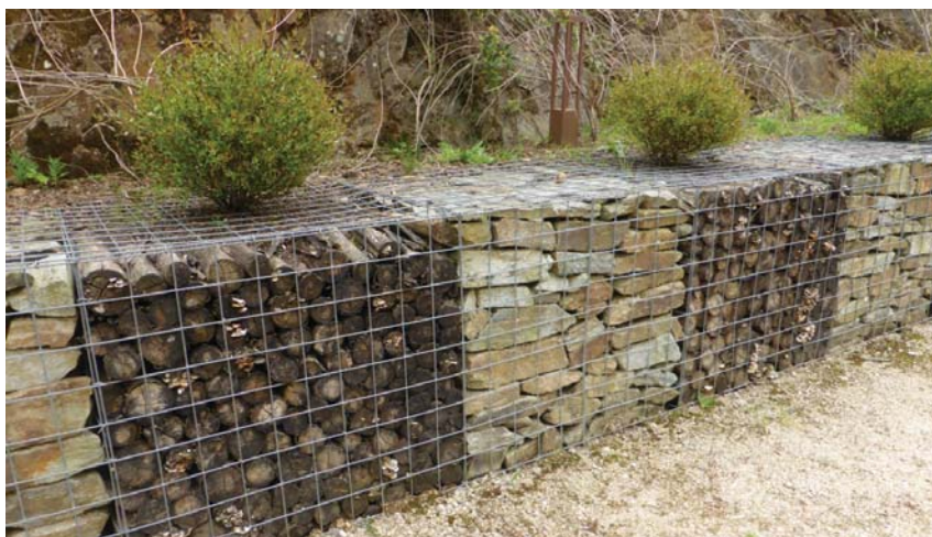
Figura 116. Muro de gavión de lousa e madeira con vexetación integrada, Xardín Literario do Gaiás (Cidade da Cultura), Santiago de Compostela
