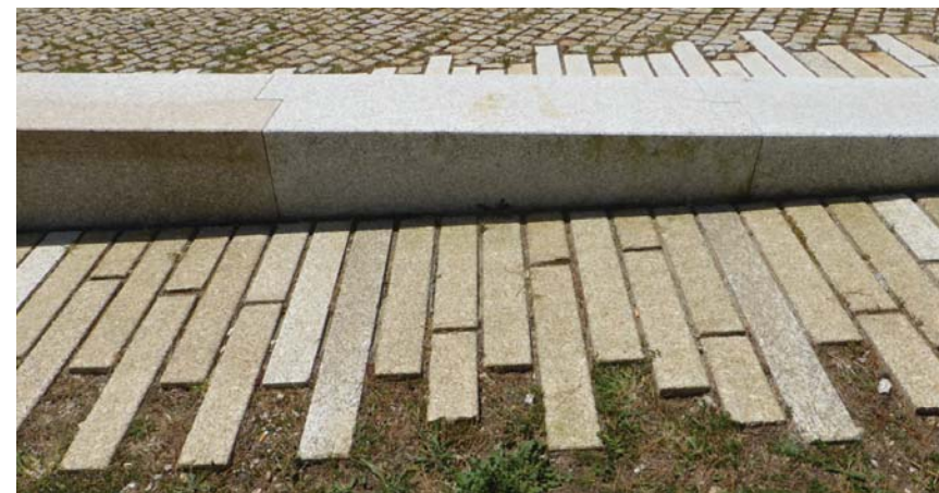
Figura 60. Distintos despieces para o granito, Miradoiro de Pedra da Ra, Ribeira
