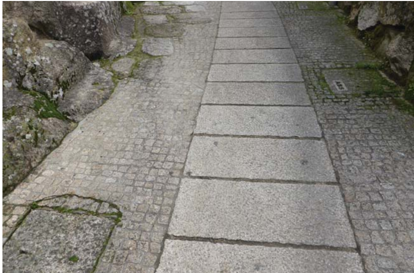
Figura 66. Adoquín de granito para resolver encontros irregulares. Pazos de Arenteiro
