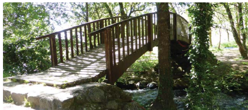
Figura 138. Pasarelas tipo ponte
