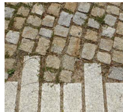
Figura 68. Aparellos de adoquín de granito
