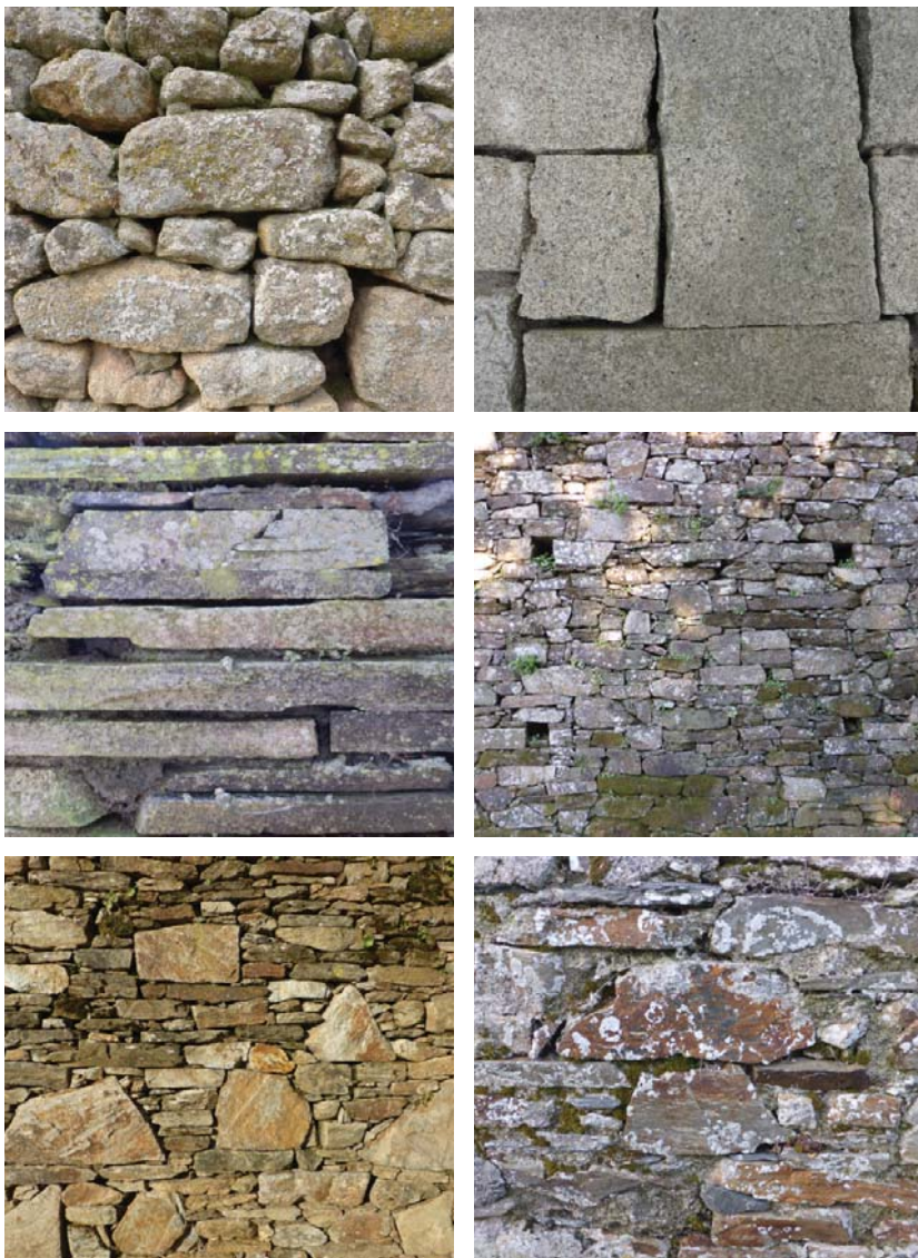
Figura 113. Aparellos de muros de cachotería
