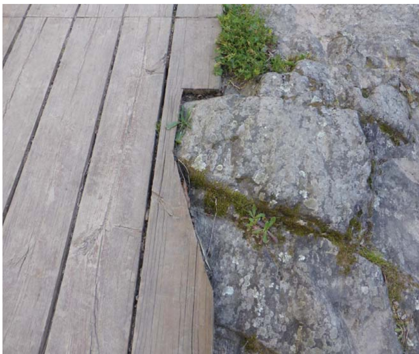
Figura 97. Encontro entre tarima de madeira e rocha existente
