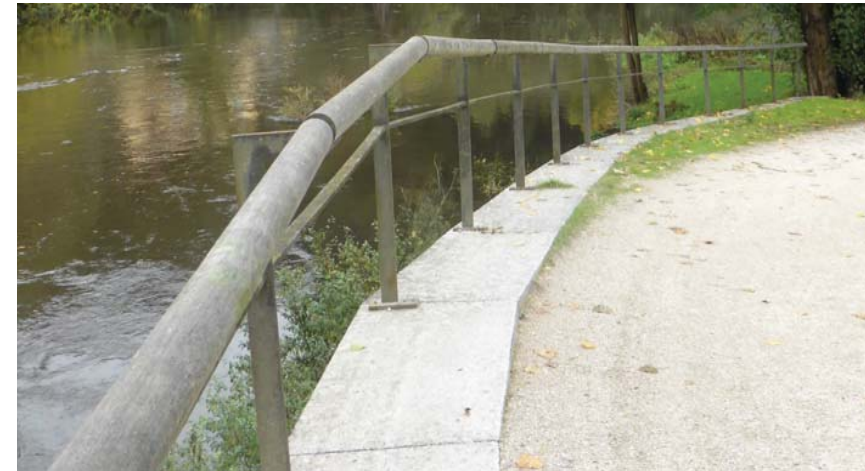
Figura 157. Pasamáns de madeira sobre montantes de aceiro en Ribadavia
