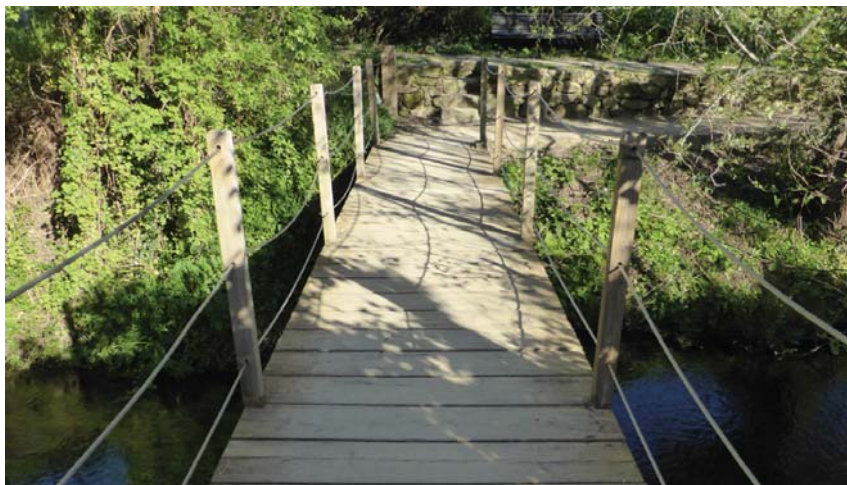
Figura 137. Ponte na senda do Río Sarela, Santiago de Compostela
