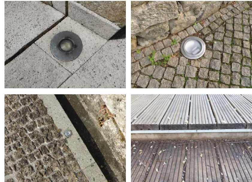
Figura 215. Luminarias integradas
