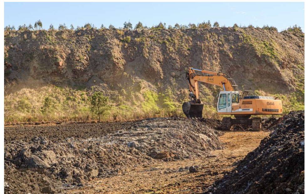
Imaxe 36. Extendido de tecnosolos. Fonte: U. Vigo.
