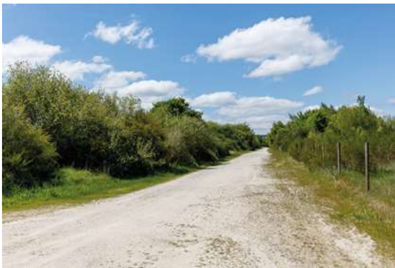
Vial de acceso realizado con pavimento permeable, respectando a vexetación autóctona nas súas marxes. Fonte: equipo redactor
