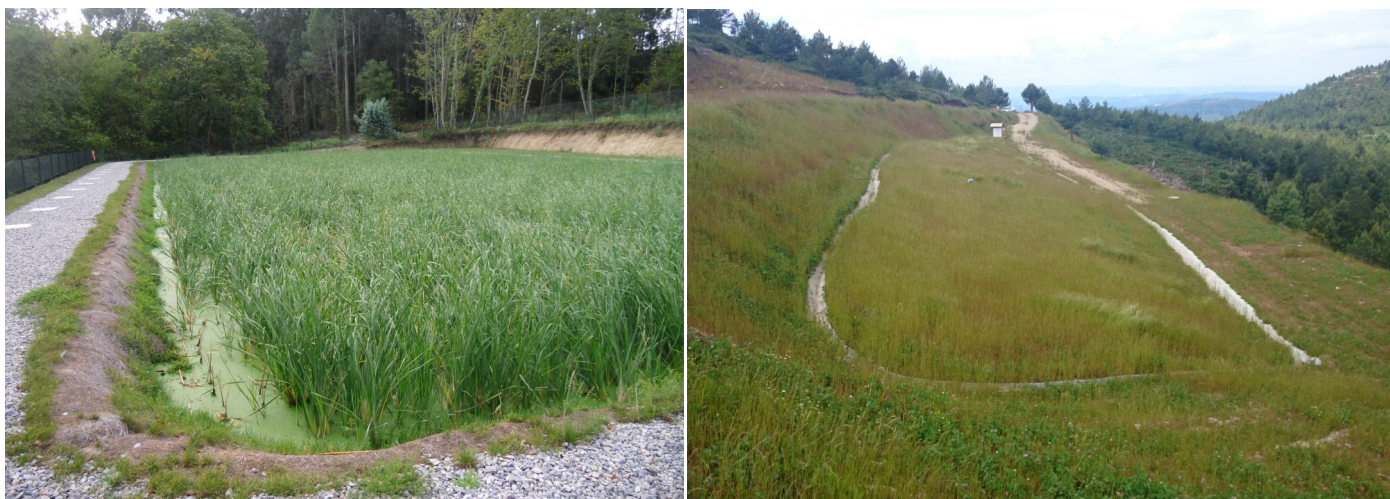
Imaxe da EDAR de Cervo, cun sistema de filtros verdes de plantas macrófitas en flotación, integrado no seu contorno (esquerda) Imaxe do vertedoiro de residuos sólidos urbanos selado e restaurado en Negueira de Muñiz (dereita)
