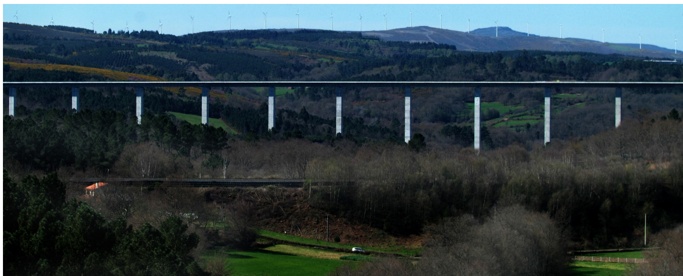
Solución en ponte do corredor ferroviario de alta velocidade no entorno de Santiago de Compostela. As infraestruturas como elementos configuradores da paisaxe
